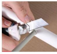
4.2.6. Через две минуты излишки ремонтного стержня обрезаются ножом.
