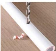
4.2.1. Отверстие в стенке трубы рассверливается сверлом D8.
