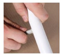
4.2.5. Разогретый ремонтный стержень с усилием вводится в отверстие в трубе на глубину, чуть большую, чем толщина стенки трубы.
